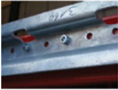
Fotografija 4: Sidrna palica za pritrditev
