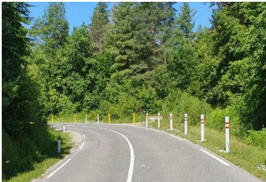
Slika 6.7 Pasivno varni stebrički rumene barve v slabo zaznavnem priključku
