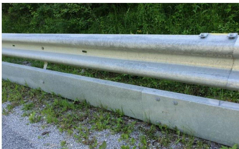
Slika 6.4 Pravilno izvedena motoristična letev
