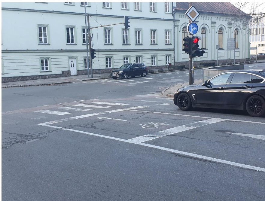
Slika 10.8 Rešitev, ki dovoljuje vožnjo kolesarja med dvema kolonoma ustavljenih vozil v semaforiziranem križišču
