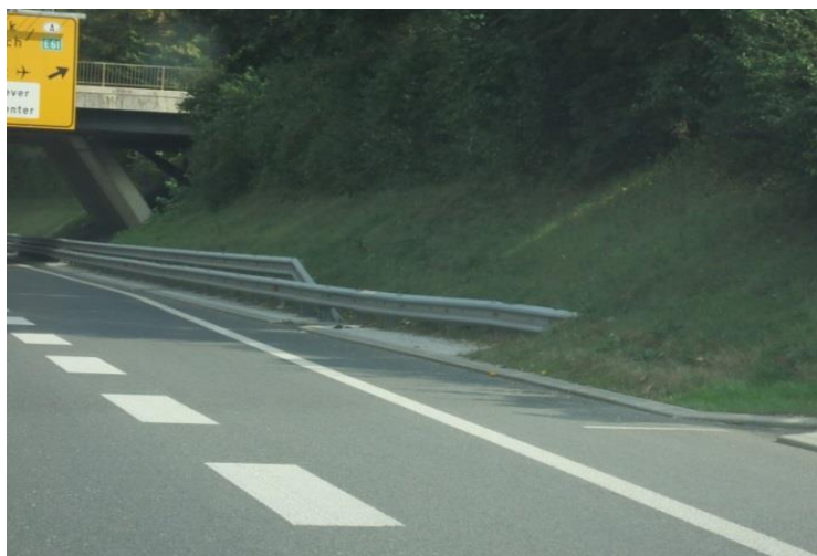
Slika 6.17 Vkopavanje odbojnika jeklene varnostne ograje v ukopno brežino
