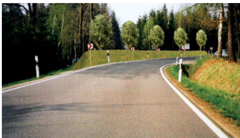
Slika 5.2 Izvedba nasipa vzdolž krivine z ozelenitvijo, z namenom boljšega vodenja motoristov skozi krivino (Vir: World Road Association – PIARC: Road Safety Manual)
