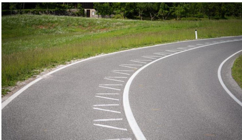
Slika 2.7 Pilotni projekt za nove talne označbe na državni cesti Rakitna – Podpeč
