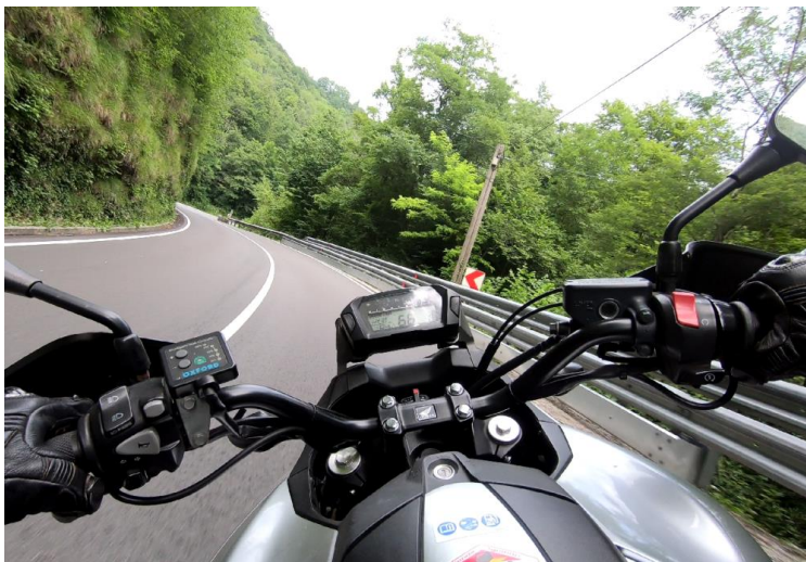
Fotografija 2: Varnostna ograja z dodatno zaščito za motoriste
