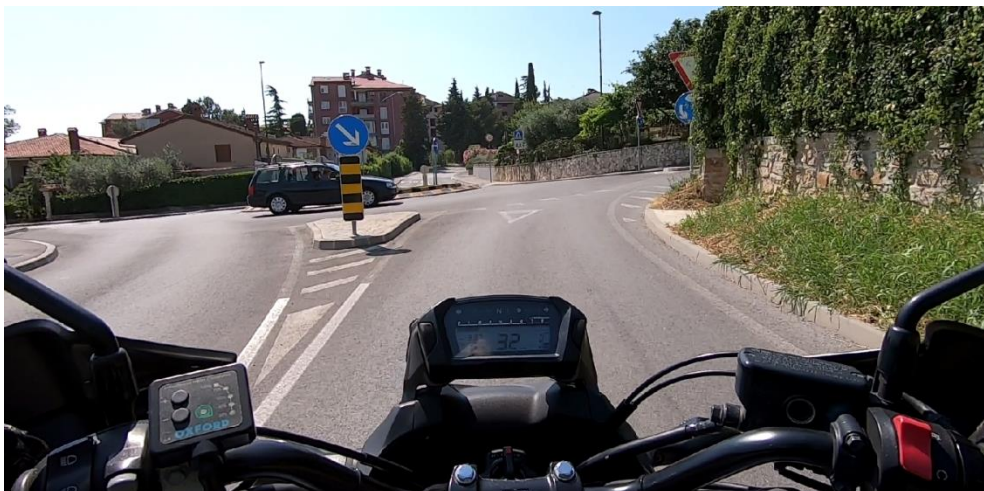
Fotografija 36: Primer netipičnega prečnega nagiba vozišča
